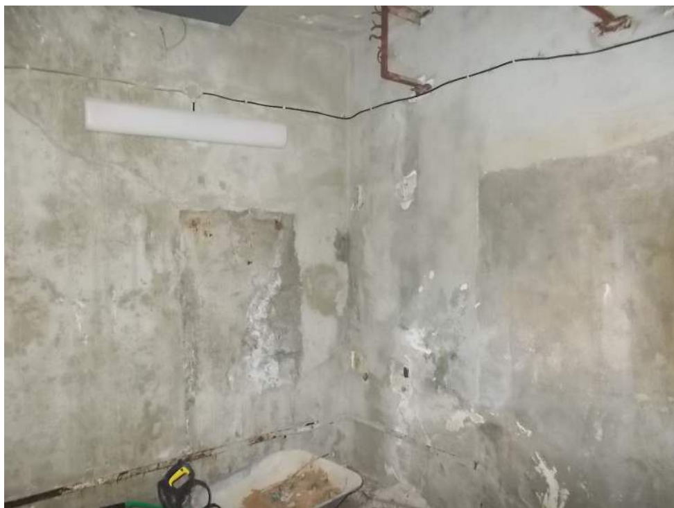
Φωτογραφία 1. Έντονες υγρασίες στα τοιχεία
