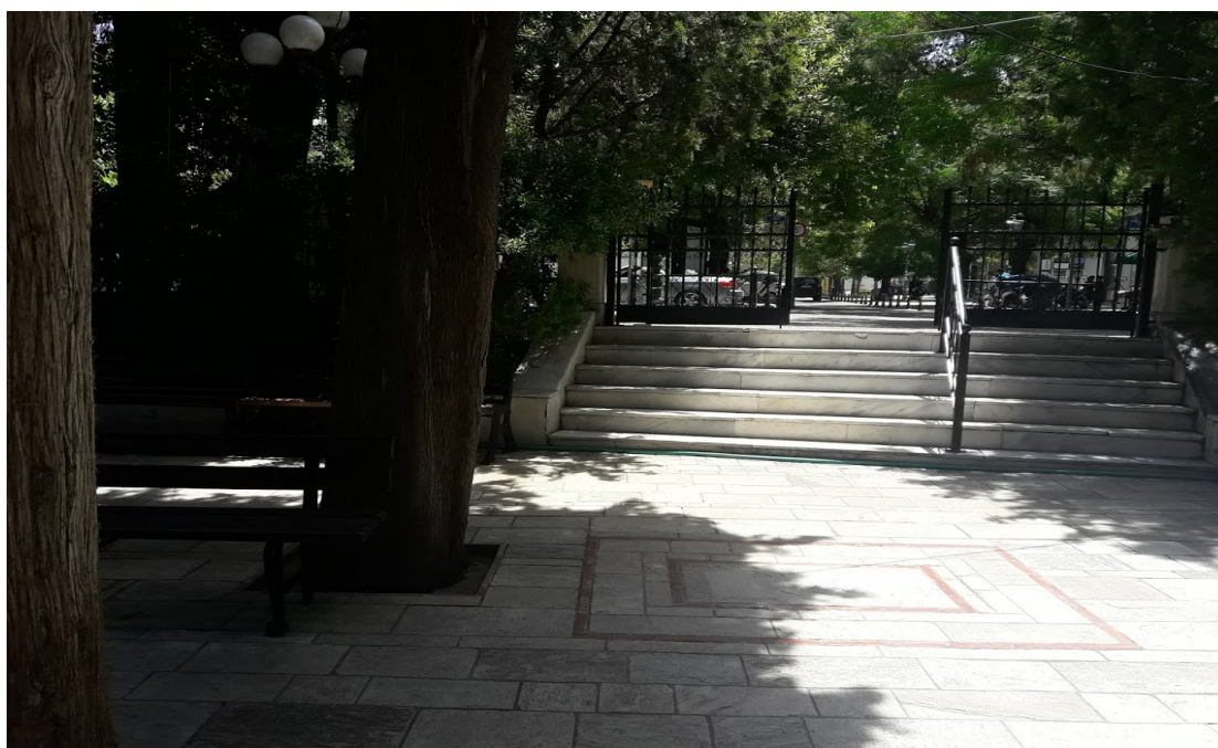
Φωτο 6 Η σκάλα προς το τμήμα του κ.χ. του Ο.Τ. 80, που ευρίσκεται στην στάθμη -1,10μ και τον αποκαλούμε περίβολο του ναΐσκου. Διακρίνεται η μαρμάρινη πλακόστρωση και τα φωτιστικά «φούσκα» που θα αντικατασταθούν
